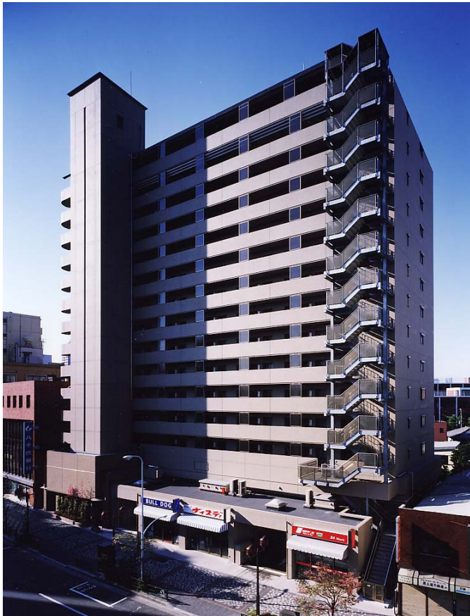
建物北面の全景
