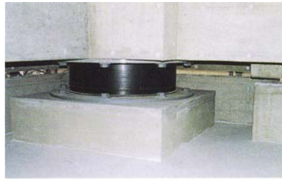
免震装置(高減衰積層ゴム)
