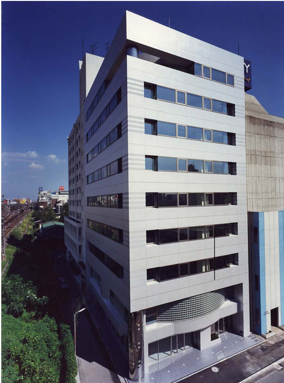
JR線路側からみた全景
